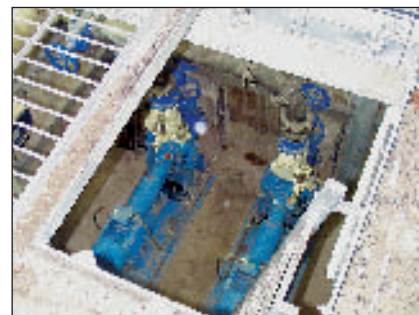
Компактная конструкция насоса серии В допускает строительство установок прямоугольного типа
