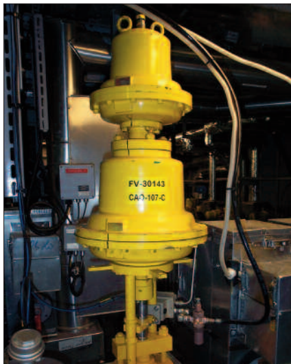
Сдвоенные приводы на теплоизолированном клапане
