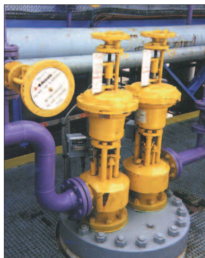
Двухпозиционные вентили Модель 2200 с устройством ручного управления – изолирование/хранения сжиженного газа
