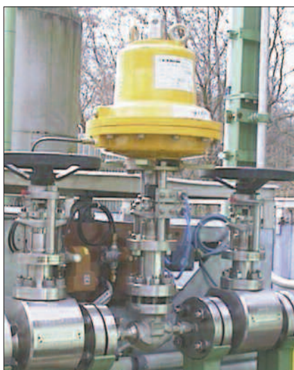
Двухпозиционный клапан (Вкл.-Выкл.) Модель 2100B – станция выгрузки CO
