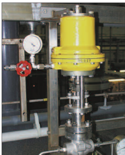
Двухпозиционный вентиль Модель 2100B – изолирование линий тяжелой воды/гелия
