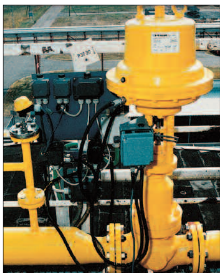
Регулирующий вентиль Модель 2100BAC - Установка хлорирования
