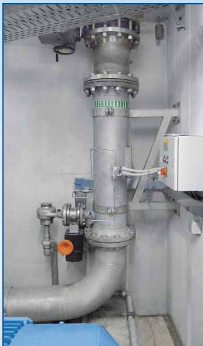
Рис. 8 Морская вода для установки по производству снега.
