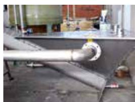
**Различные виды оборудования по удалению песка.** Извлекают песок на стадии механической водоочистки.
