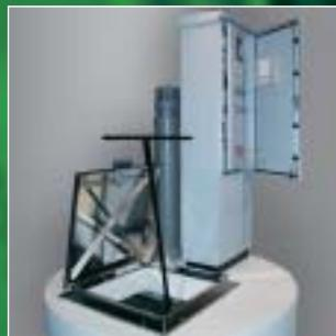
**Автоматические установки пожаротушения РР - IC** - это комплексные технологические насосные системы, предназначенные для запитывания автоматических систем пожаротушения (спринклерные и орошающие установки, а также орошающие установки с дозировкой пенообразующего средства) выполненные в форме функциональных модулей.
