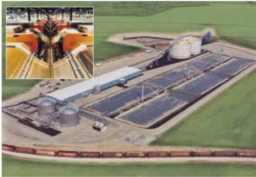
46 установок Rotoform на одном заводе грануляции серы фирмы Shell в Канаде
