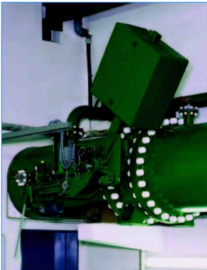
Поворотно-дисковый клапан ERHARD с гидроприводом и противовесом для воды
