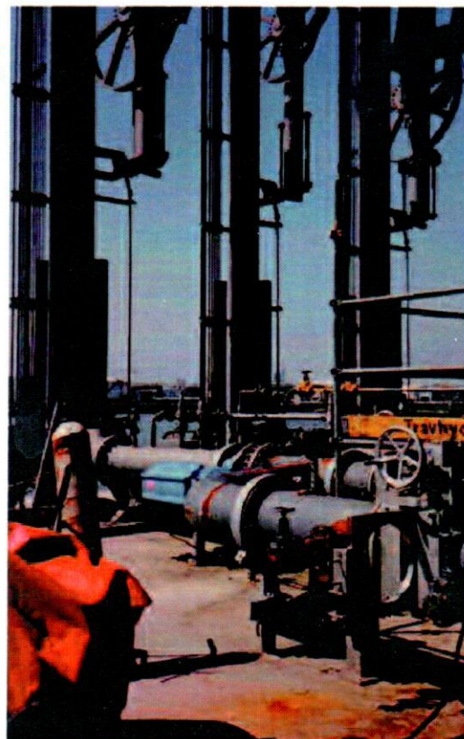
Заглушка ONIS PLR 400 (16") на загрузочных рукавах для отгрузки нефти
