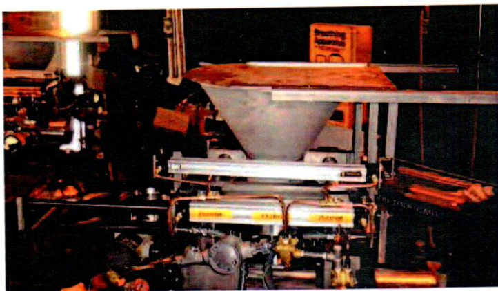
Полностью автоматизированная заглушка ONIS в котле для обработки кофейных зерен - FOLGERS COFFEE - США
