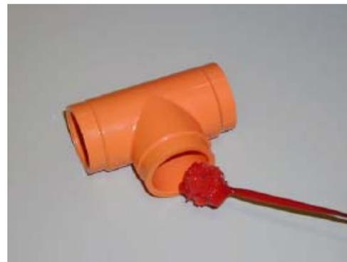
Нанесите толстый равномерный слой клея на наружную сторону конца трубы. Нанесите слой клея на гнездо фитинга. Трубы номинальным диаметром от 32 мм и более, всегда следует смазывать клеем дважды. Вначале необходимо нанести клей на конец трубы, затем на гнездо фитинга, а затем снова на конец трубы.
