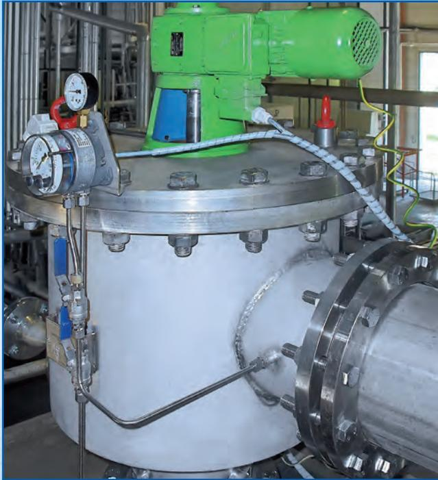
Рис. 8 Фильтрация охлаждающей воды на заводе по производству пластмасс.
