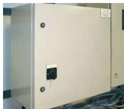
Силовой шкаф RK100
